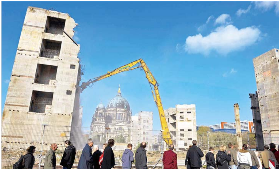
Die Abrissarbeiten am einstigen Palast der Republik in Berlin schreiten sichtbar voran. Bagger tragen zurzeit die Reste der Treppenhäuser ab und geben so den Blick auf den Dom frei. Im Frühjahr soll die Demontage des DDR-Prestigebaus abgeschlossen sein. Der Palast macht der Errichtung des Humboldt-Forums Platz, dessen Eröffnung für 2013/14 geplant ist. Bild: dpa
